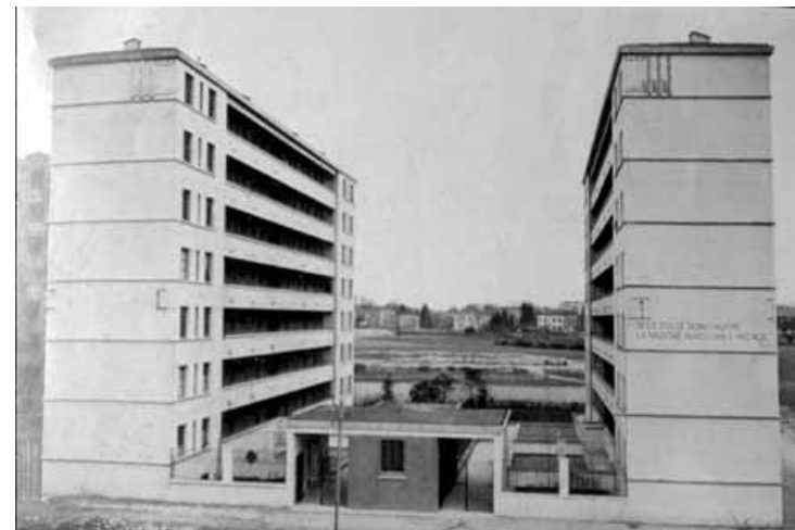
F. SANTINI e UFFICIO TECNICO ISTITUTO FASCISTA CASE POPOLARI, Bologna, Case "popolarissime" in via Vezza. Edifici con distribuzione a ballatoio. 1934 - 35, fotografia.
