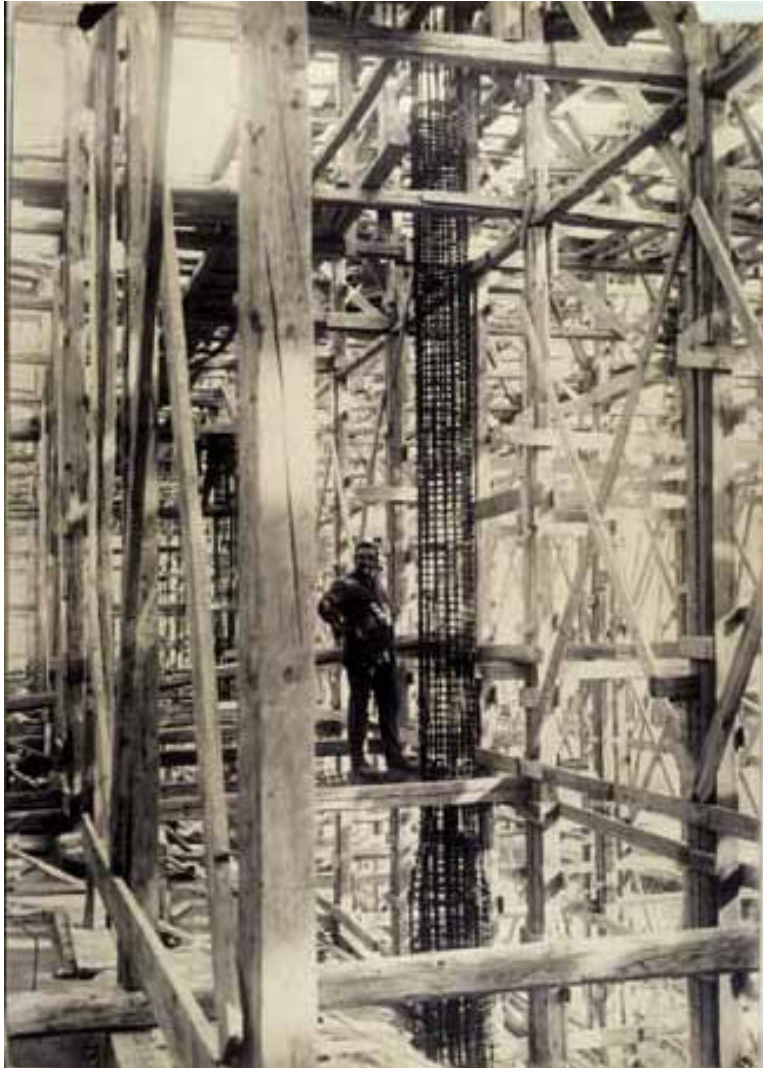
U. COSTANZINI, Veduta delle carpenterie e delle armature per il getto della pensilina coperta del Littoriale a Bologna. 1926, fotografia.
